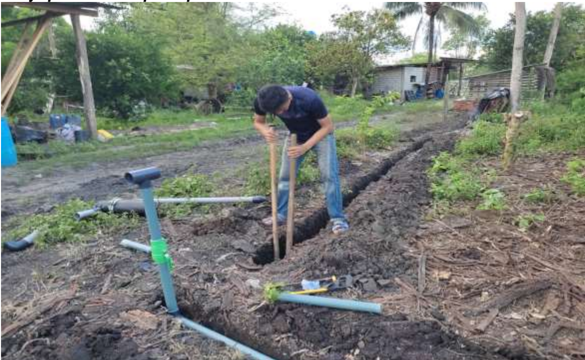
Figura 16. Zanja para tubería principal
