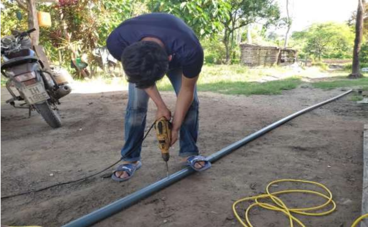
Figura 17. Orificios para conexión con cintas de riego
