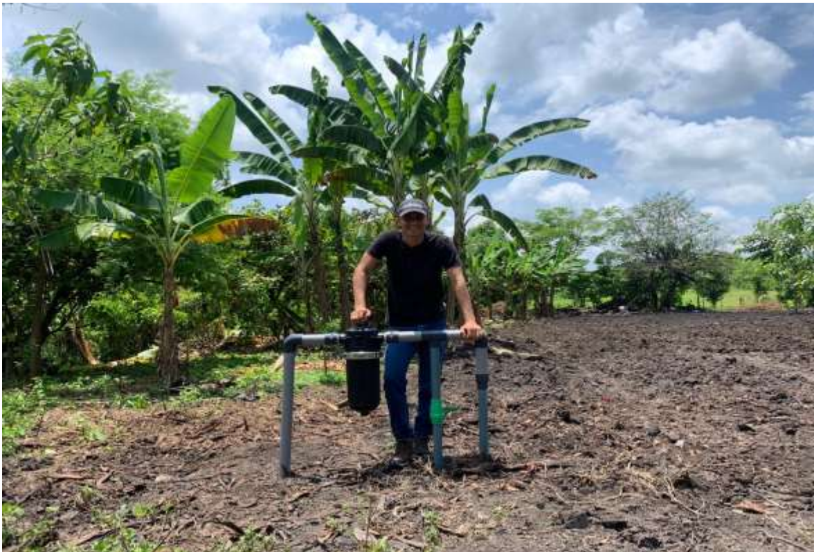
Figura 20. Sistema de filtrado
