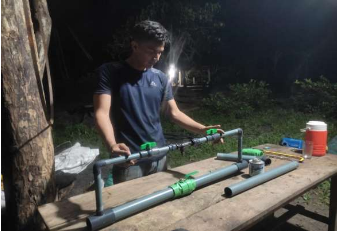
Figura 19. Elaboración de la estructura del sistema Venturi
